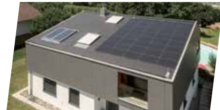
In die Bedachung integrierte Solaranlage
