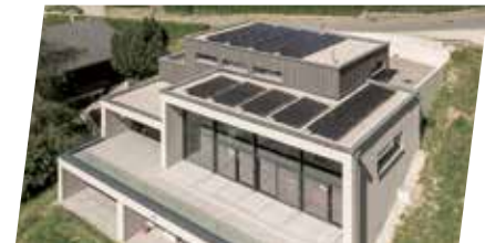
In die Bedachung integrierte Solaranlage
