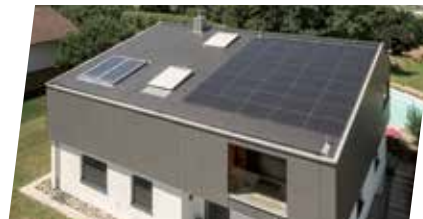
Installation intégrée en toiture
